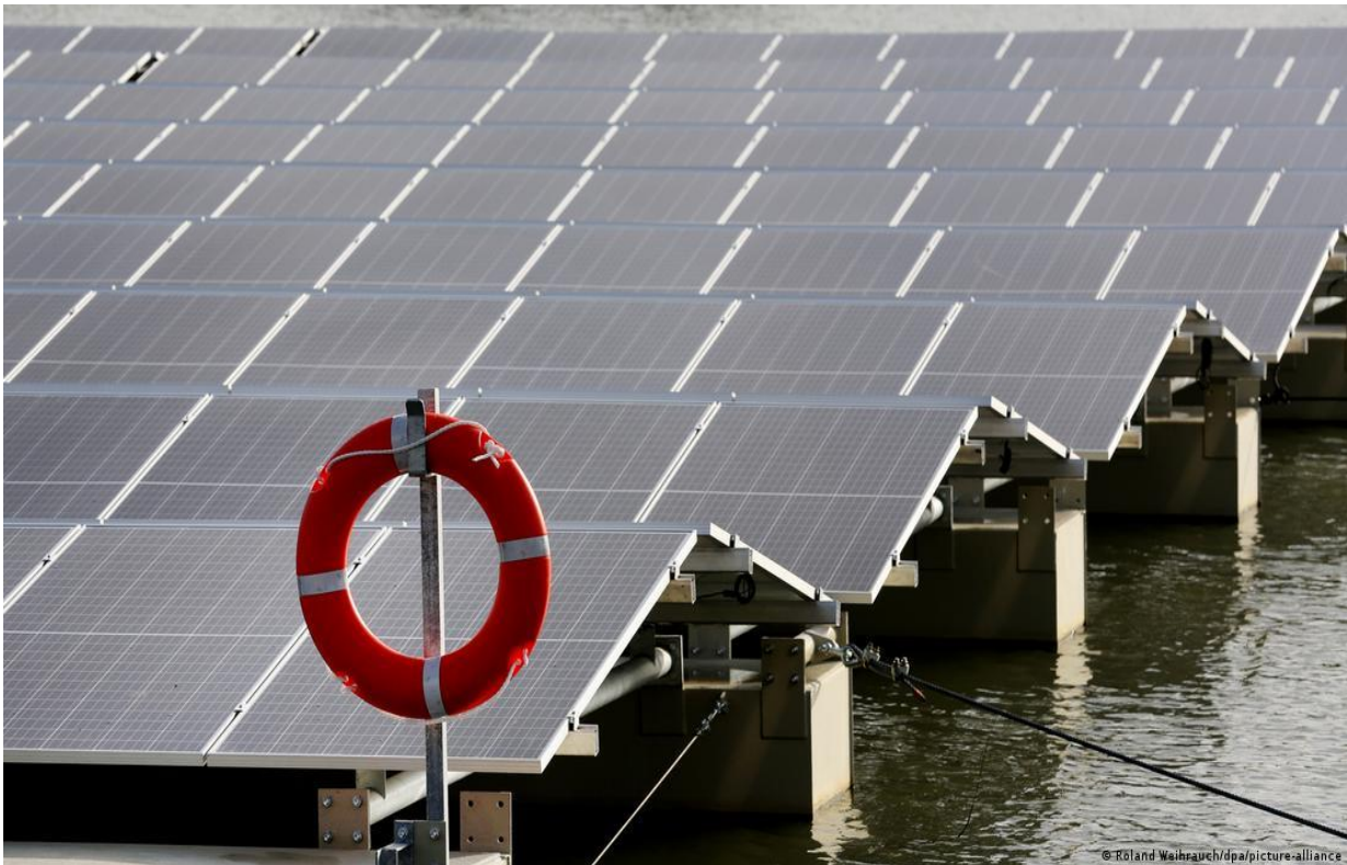
Рис.2. Так вблизи выглядит плавучая солнечная электростанция в Веце: 90 понтонов и 2000 панелей
