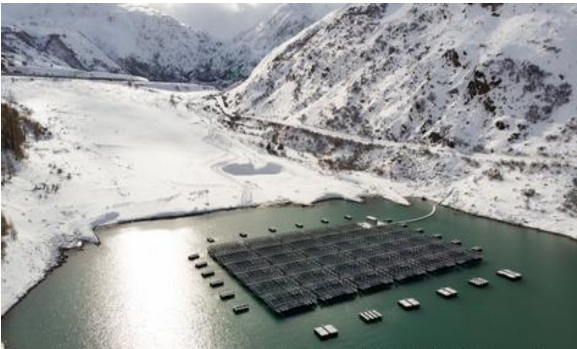
Рис.3. Плавучая солнечная электростанция на озере Туль в Швейцарских Альпах
